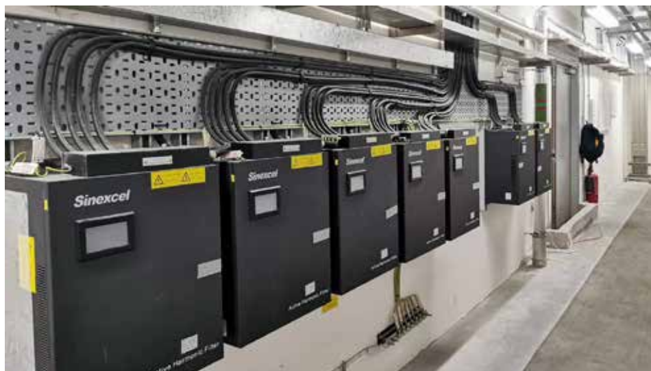
Пример применения активных фильтров АНФ (400 В) для индивидуальной компенсации нелинейных нагрузок
