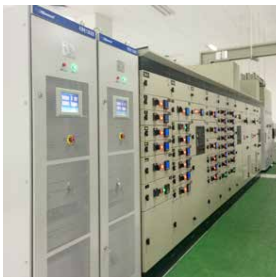
Активные фильтры шкафного исполнения с панелями оператора размером 7"
