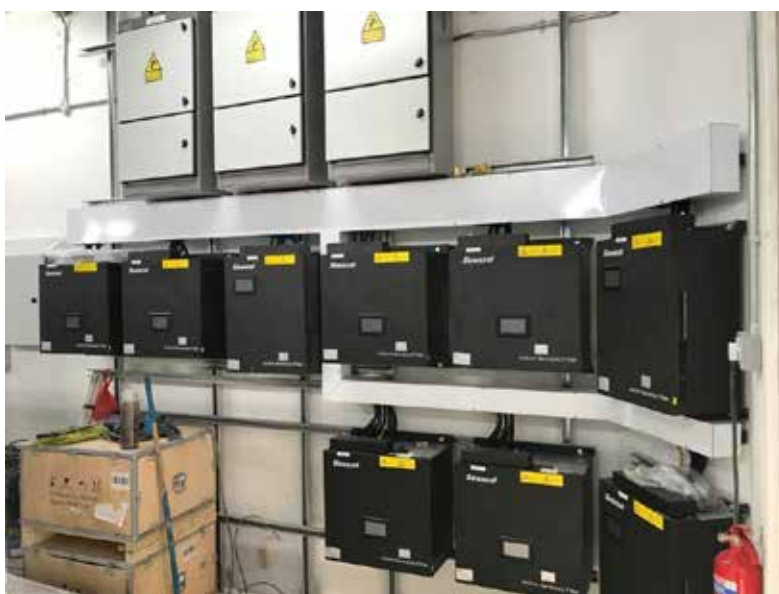
Пример применения активных фильтров АНФ (690 В) для индивидуальной компенсации нелинейных нагрузок
