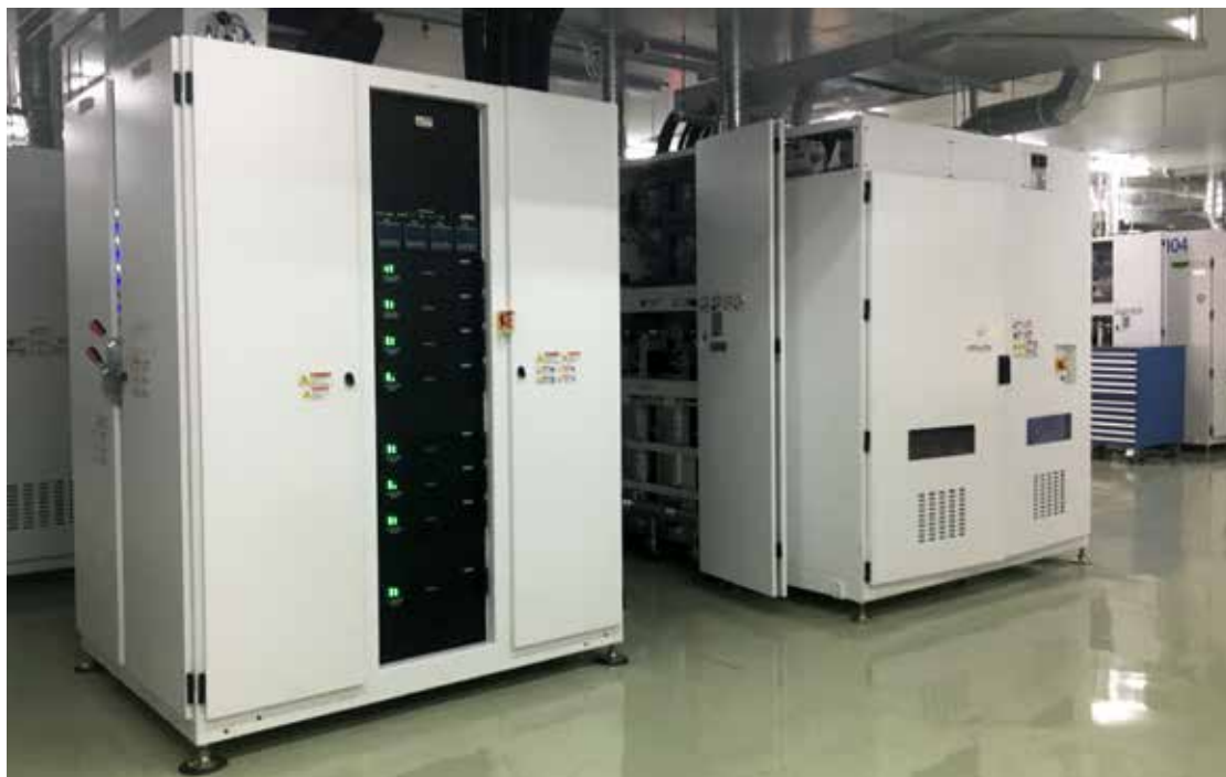
Установка активных фильтров ASVG на производстве по выращиванию кристаллов
