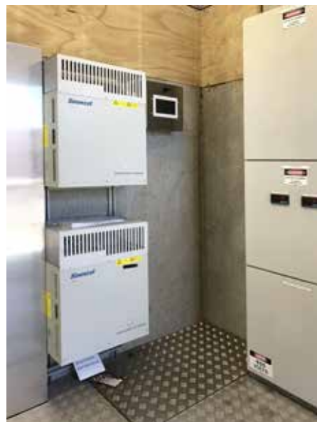
Активные фильтры-компенсаторы ASVG навесного исполнения
